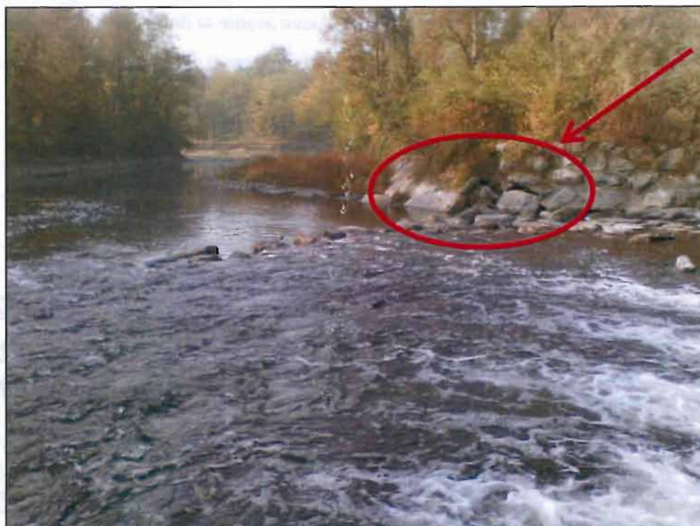
Figura 4 – Vista verso valle della sponda destra in massi e del fondo in massi a valle della briglia
